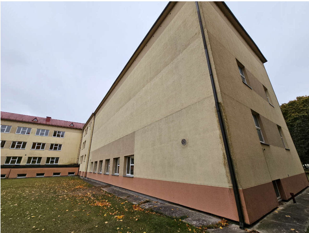
Pav. Remontuojamos pastato daliese vaizdas iš išorės
